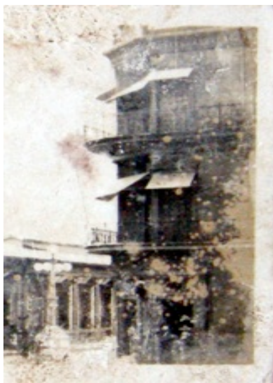
Imagen 4. Detalle de la fotografía 1. San Salvador, C.A. que muestra la presencia de manchas por deterioro químico, AGN.
